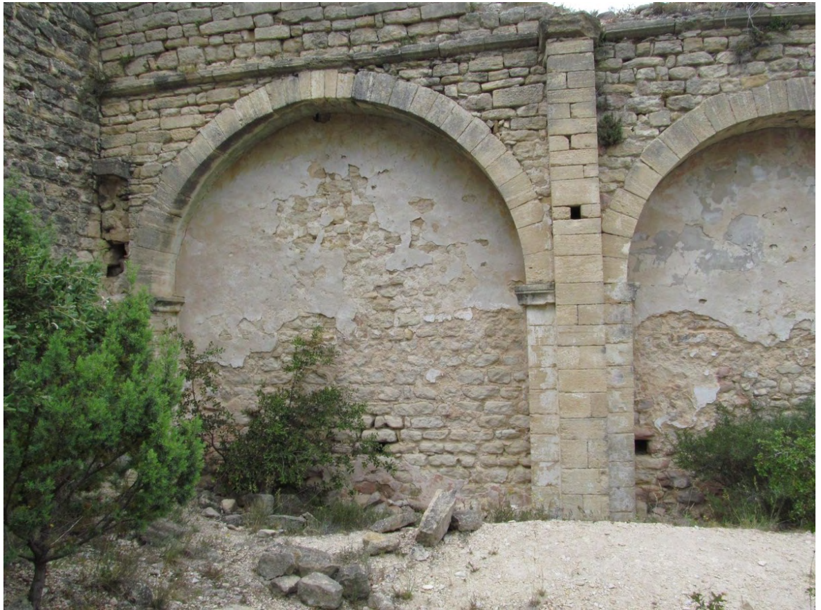
Ruines de la chapelle St. Alban
