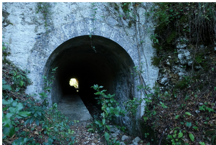
L'un des deux tunnels du canal
