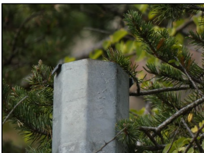
Poteau France télécom bouché pour éviter l'entrée aux oiseaux troglodytes
