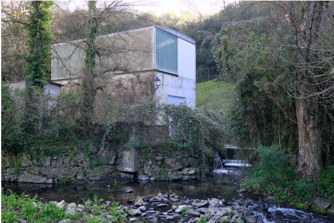
Figure 13: Captage de la source de la Foux
