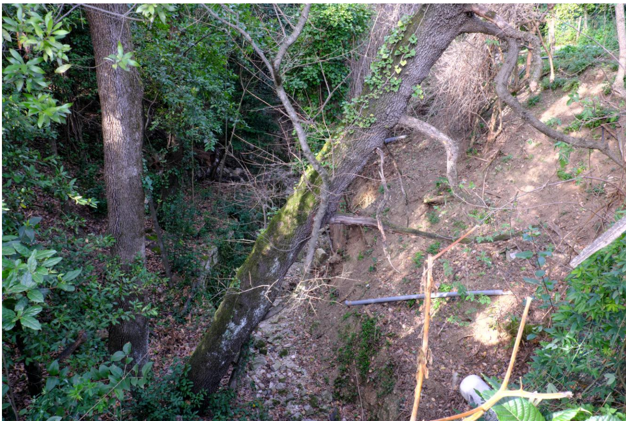
Figure 12: effondrement d'une cavité liée à la dissolution du gypse
